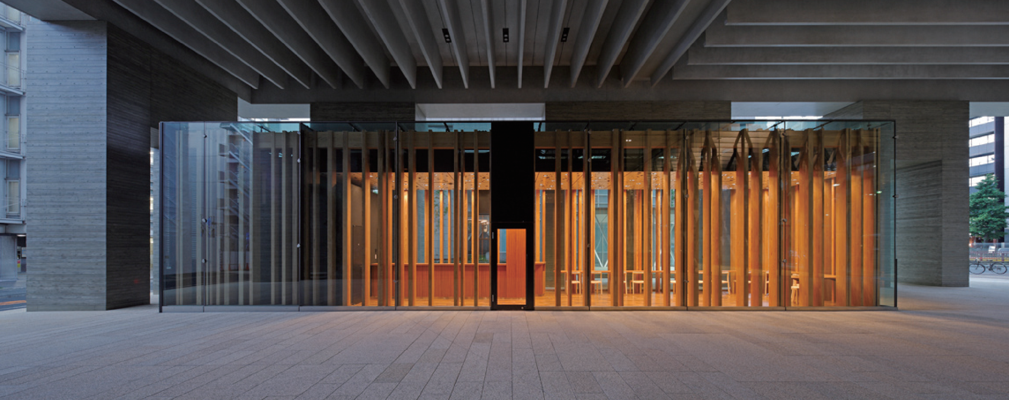
1階ピロティ空間から見る外観。木が林立するイメージが具現化している。ホルバーは不燃処理したスギ材を、清水建設の東京木工場で加工製作した。
